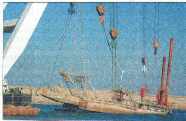
Судоподъемные работы в порту Умм-Каср (Ирак)
